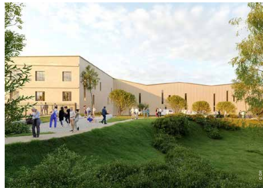
Sous l'impulsion de la Métropole, une ancienne friche des berges de la Seine à Argenteuil devient l'une des plus belles réussites du concours IMGP.
