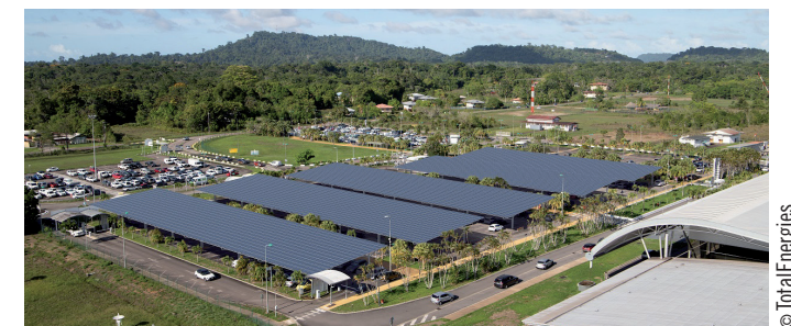
Les ombrières photovoltaïques implantées sur les parkings de l'aéroport Félix Eboué – 1.5 MWc – Mise en service fin 2024.
