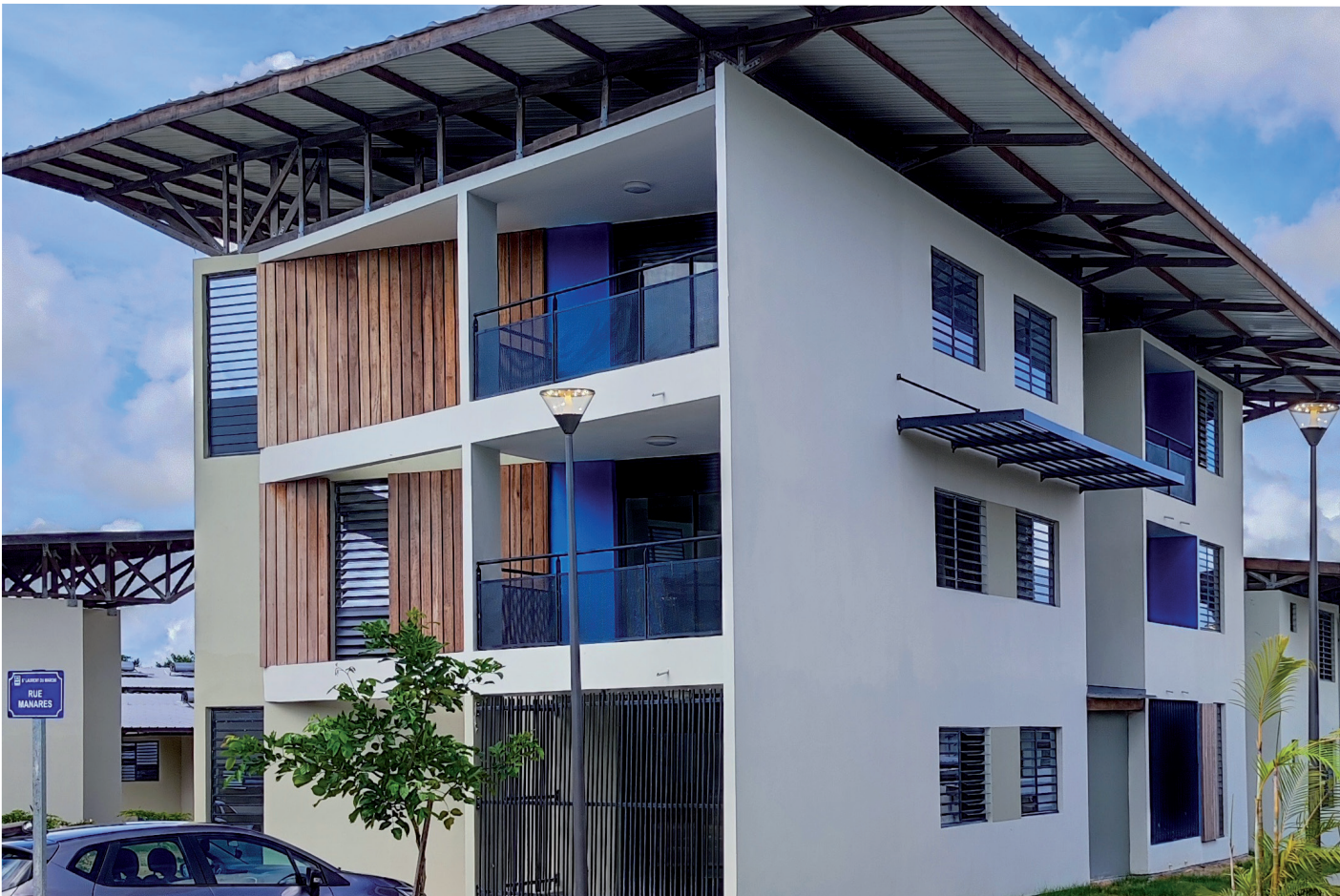
Opération « Malu » à Saint-Laurent du Maroni - 98 logements locatifs sociaux (LLS).
