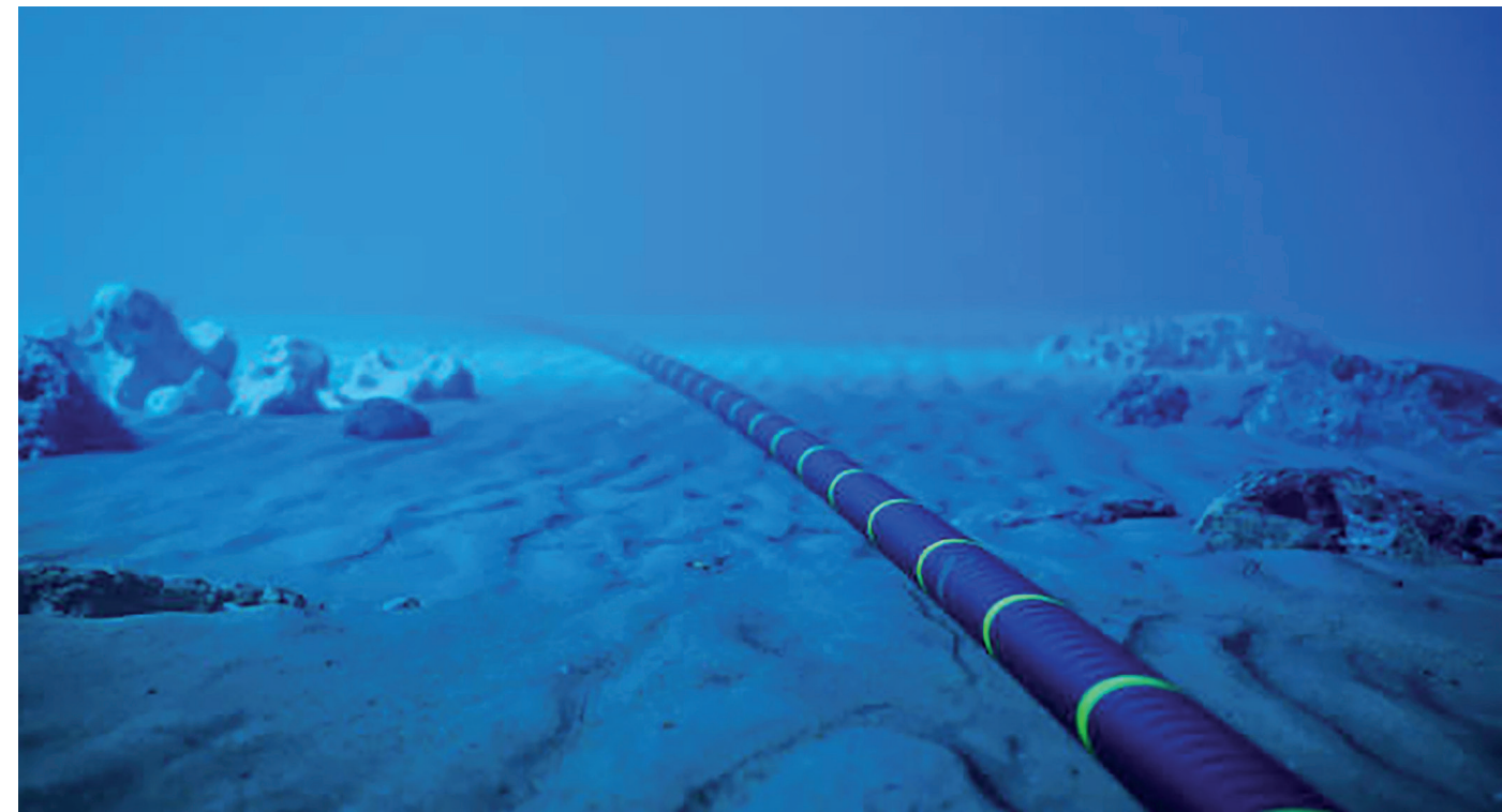
Le câble sous-marin reliant la Guyane à l'Europe renforcera la souveraineté numérique et permettra une plus grande connectivité fibre.
